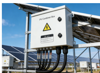
光伏组串汇流箱
