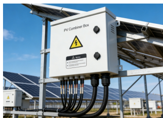
光伏组串汇流箱
